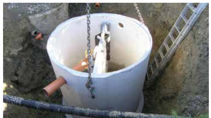
Einbau eines monolithischen Behälters für eine Anlage mit technischer Belüftung
