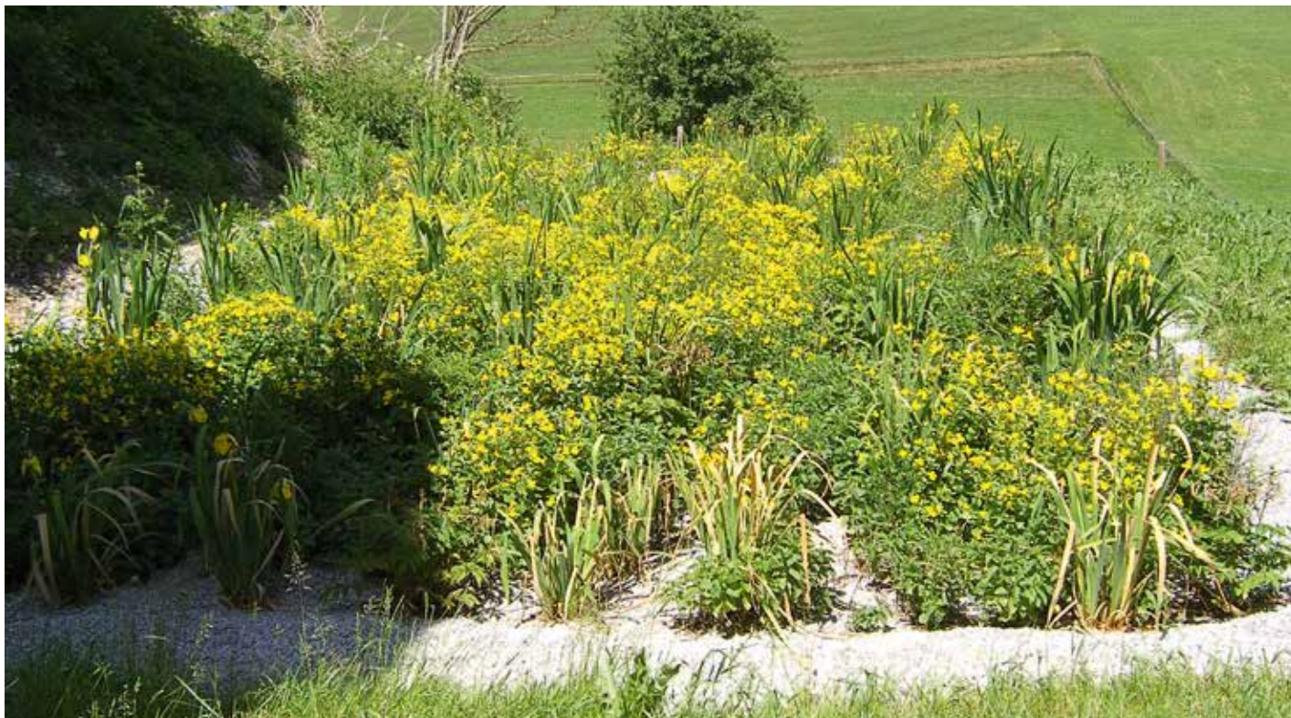
Bepflanzter Bodenfilter ohne technische Belüftung
